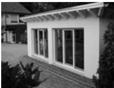
Gemeindezentrum Wellensiek, Anbau am Kindergarten
